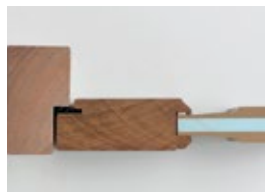
Doorsnede geïsoleerde deur 54 mm
